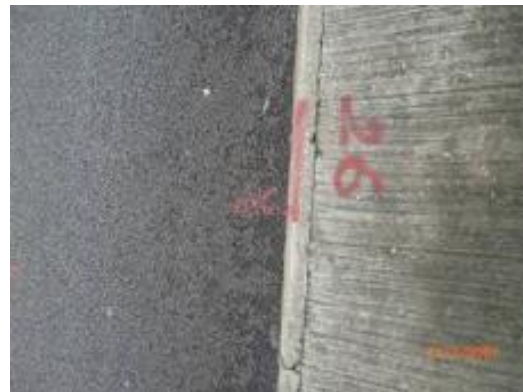
Fig. 2 Site marking 圖二. 現場標記
